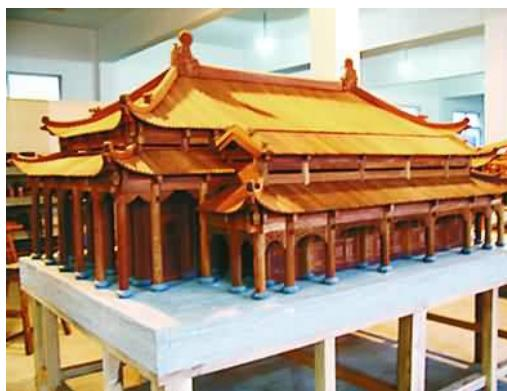
的雄偉和壯觀：長達44米、近2個人高的斗拱成品大樣被排成4排；每一個拱、每一根昂都有20多厘米寬，近1米長；木構件總數達到了8000多個，其中光斗有3000個，5.5米長的梁500多根。
